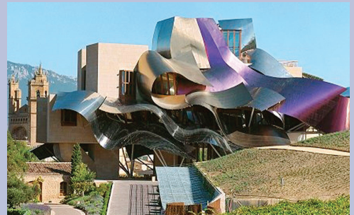
Bodegas Marqués de Riscal Arquitecto Frank Ghery Fuente: http://www.diariocritico.com
